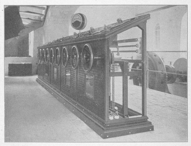
Fig. 6. - Tableaux de manœuvre et de distribution.
