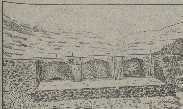
Cube : 1611 m<sup>3</sup> de béton, 557 m<sup>3</sup> de maçonnerie en chaux hydraulique de Vallorbe seconde qualité. Les tuyaux de prise de charge ont 2m,75 de diamètre.
