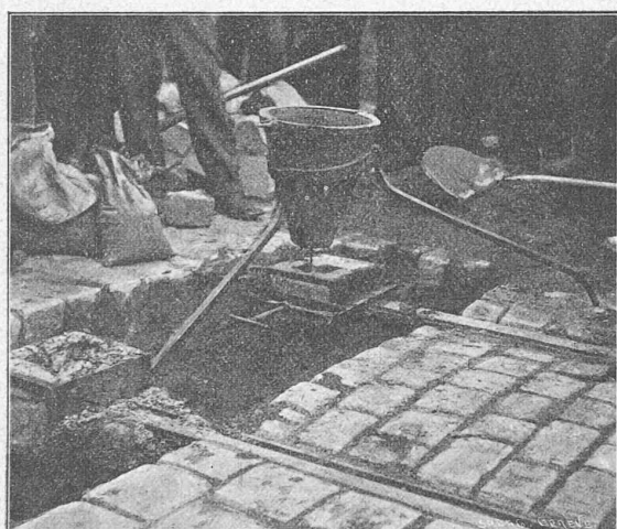
Fig. 4. — Disposition des appareils pour la soudure d'un joint de rails.
