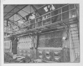
Fig. 39. — Vue générale de la batterie de chaudières.
