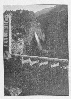
Fig. 18. — Conduite forcée de 1<sup>m</sup>,90 de diamètre intérieur.
