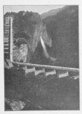
Fig. 18. — Conduite forcée de 1<sup>m</sup>,90 de diamètre intérieur.
