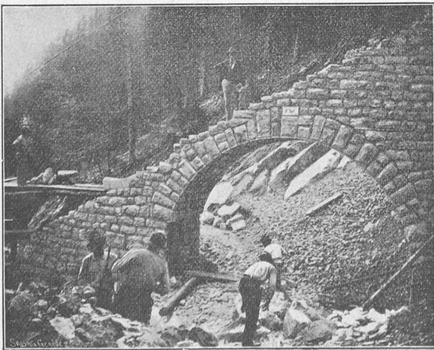
Fig. 10. — Voûte sur la « Charrière ».
