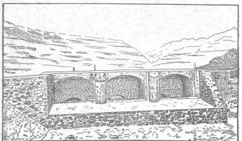
Cube: 1611 m³ de béton, 557 m³ de maçonnerie en chaux hydraulique de Vallorbe seconde qualité. Les tuyaux de prise de charge ont 2m,75 de diamètre.
