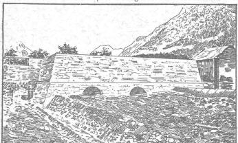
Cube: 1611 m³ de béton, 557 m³ de maçonnerie en chaux hydraulique de Vallorbe seconde qualité. Les tuyaux de prise de charge ont 2m,75 de diamètre
