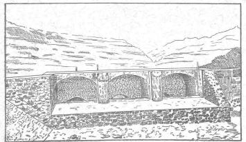
Cube: 1611 m<sup>3</sup> de béton, 557 m<sup>3</sup> de maçonnerie en chaux hydraulique de Vallorbe *seconde qualité*. Les tuyaux de prise de charge ont **2<sup>m</sup>**,**75** de diamètre.
