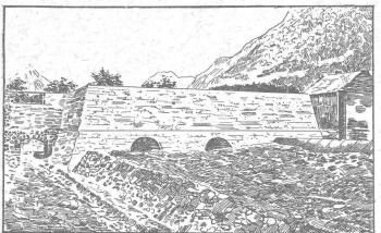
Cube: 1611 m³ de béton, 557 m³ de maçonnerie en chaux hydraulíque de Vallorbe seconde qualité. Les tuyaux de prise de charge ont 2m,75 de diamètre
