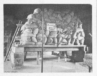
Fig. 4. — Essai de charge de la poutre Nº 2.
