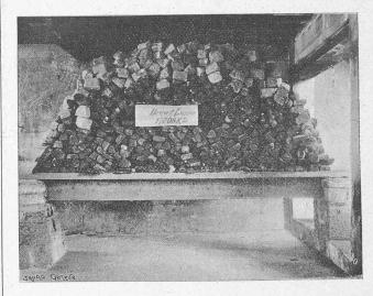
Fig. 2.] — Essai de charge de la poutre  $N^{\circ}$  1.
