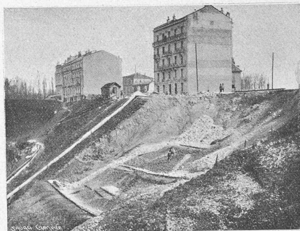
Fig. 4. — Vue prise après l'éboulement du remblai des Pilettes.
