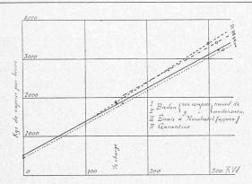
Fig. 43. — Résultats d'essais de la turbo-dynamo de 300 kw. de l'usine de Neuchàtel.
