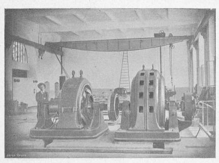
Fig. 46. — Usine de Neuchâtel. Nouveau groupe convertisseur de 250 kilowatts.
