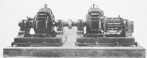
Fig. 23. - Survolteur-dévolteur.
