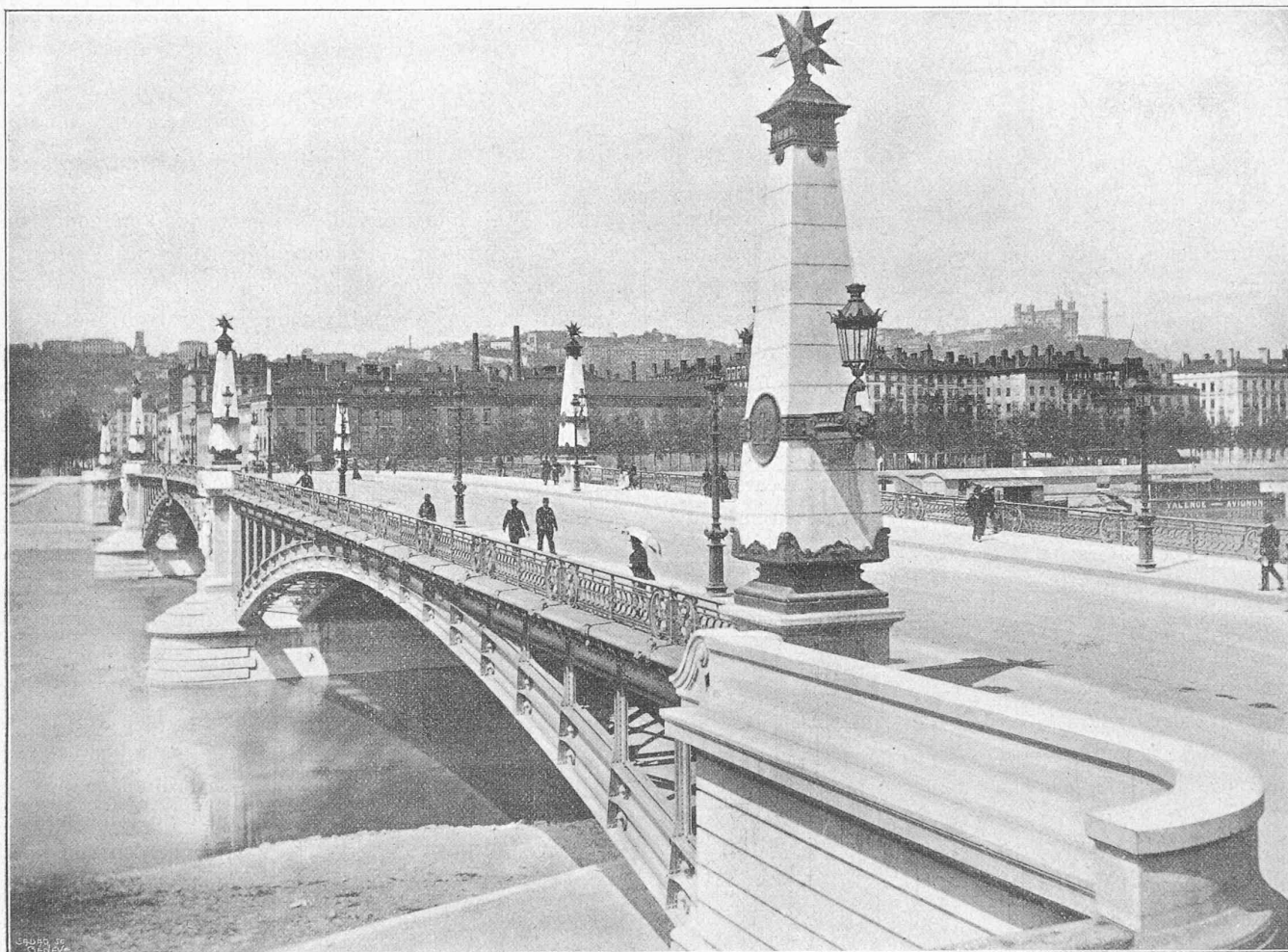
Fig. 6. — Pont du Midi, à Lyon.
