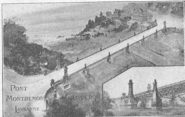
C'est un viaduc de six travées métalliques arquées, simulant des arches en treillis.
