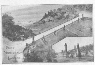
C'est un viaduc de six travées métalliques arquées, simulant des arches en treillis.
