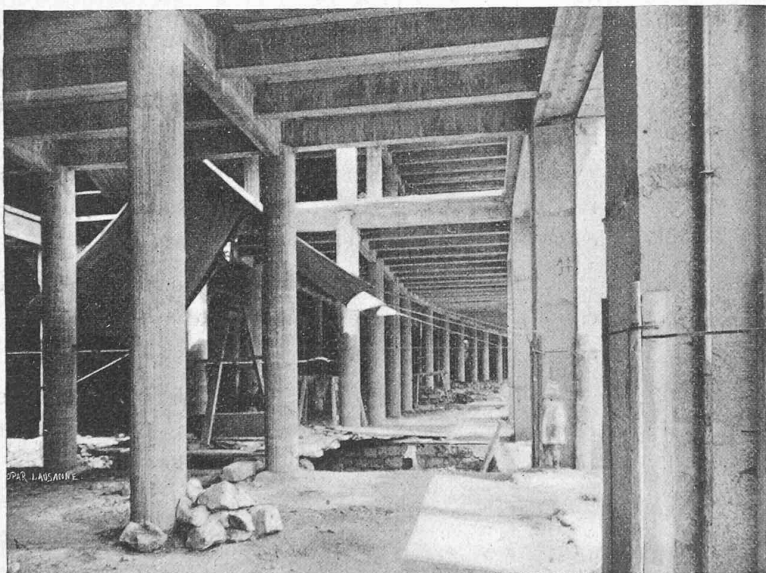
Fig. 6. — Colonnes terminées.
