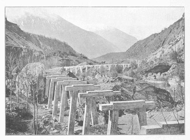
Fig. 2. — CONSTRUCTION DU CANAL EN CIMENT. (Chevalets en ciment armé destinés à supporter le canal).
