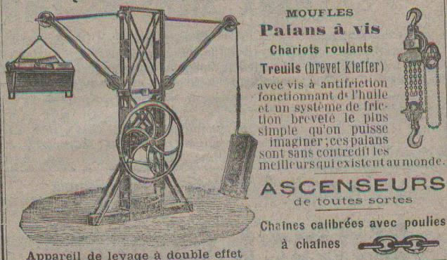
Appareil de levage à double effet
