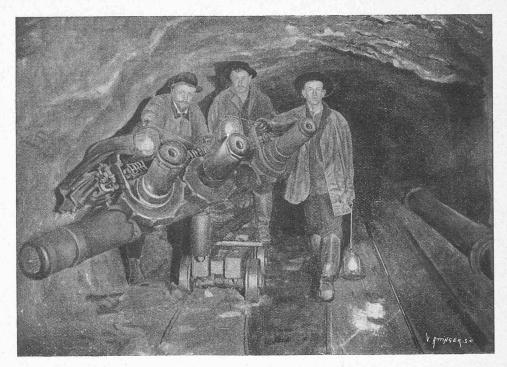
Fig. 6. — Le tunnel près de « l'avancement ». Perforatrice au repos.
