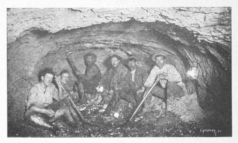
Fig. 8. - Le fond du tunnel au moment du marinage.
