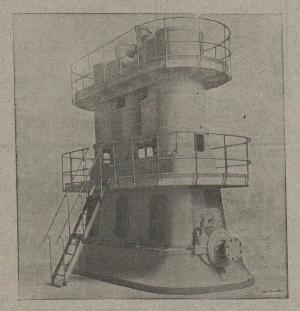
Machine à triple expansion ayant fonctionné à l'Exposition de 1900 (Galèrie des Groupes électrogènes)
