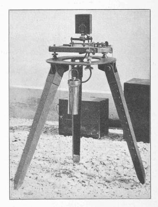
Fig. 7. - Support pour les lampes avec lampe et générateur d'acétylène
