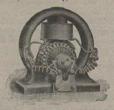
RÉGULATEUR AUTOMATIQUE, syst. R. Thury, nouveau modèle, sans contacts électriques, appliqué au réglage du courant, aux réducteurs d'accumulateurs, etc.
