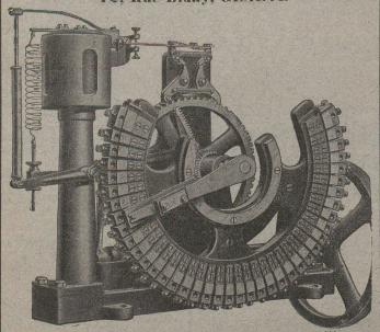
RÉGULATEUR AUTOMATIQUE, syst. R. Thury, nouveau modèle, sans contacts électriques, appliqué au réglage du courant, aux réducteurs d'accumulateurs, etc.
