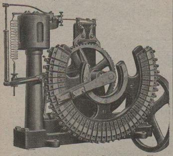
RÉGULATEUR AUTOMATIQUE, syst. R. Thury, nouveau modèle, sans contacts électriques, appliqué au réglage du courant, aux réducteurs
