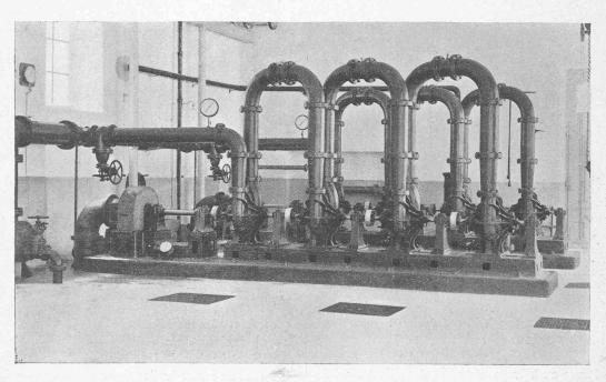
POMPES CENTRIFUGES DE COMBE-GAROT (VAL-DE-TRAVERS). Propriété de la commune de Neuchâtel. 180 chevaux; 87 mètres.
