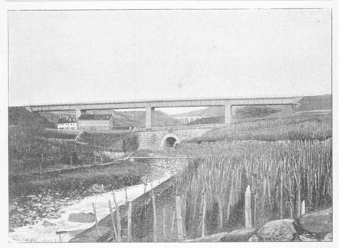
Fig. 4. — Viaduc en tôle sur la Paudèze.
