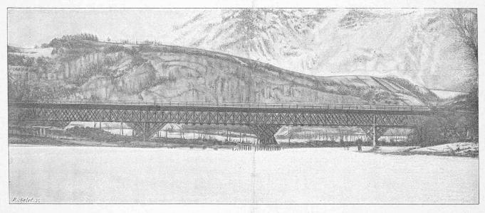
Fig. 10. — Pont provisoire en charpente sur le Rhône, près Saint-Maurice.
