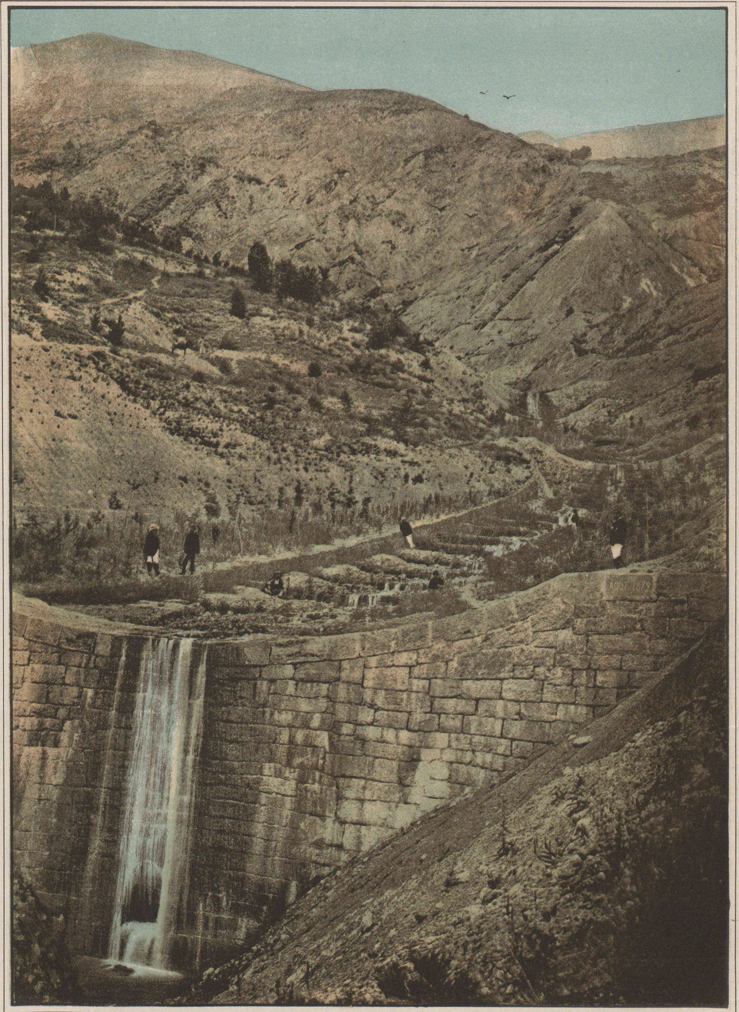
GRAND BARRAGE DU TORRENT DU BOURGET
