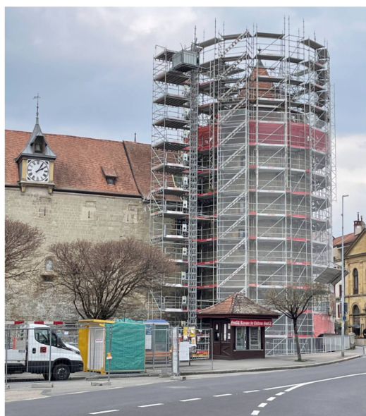
Figure 1. Vue de l'objet d'étude. La tour nord-est du château d'Yverdon-les-Bains, entourée d'échafaudages, a été photographiée au printemps 2025.
