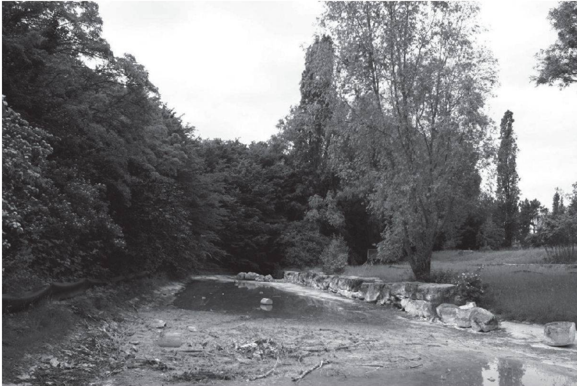
Figure 1.—Etang de Vidy en cours de vidange pendant les travaux de 2010. A gauche: barrière mise en place pour empêcher la migration des écrevisses, A droite: enrochements problématiques chaulés, puis bétonnés pour ne pas offrir de refuges aux écrevisses.
