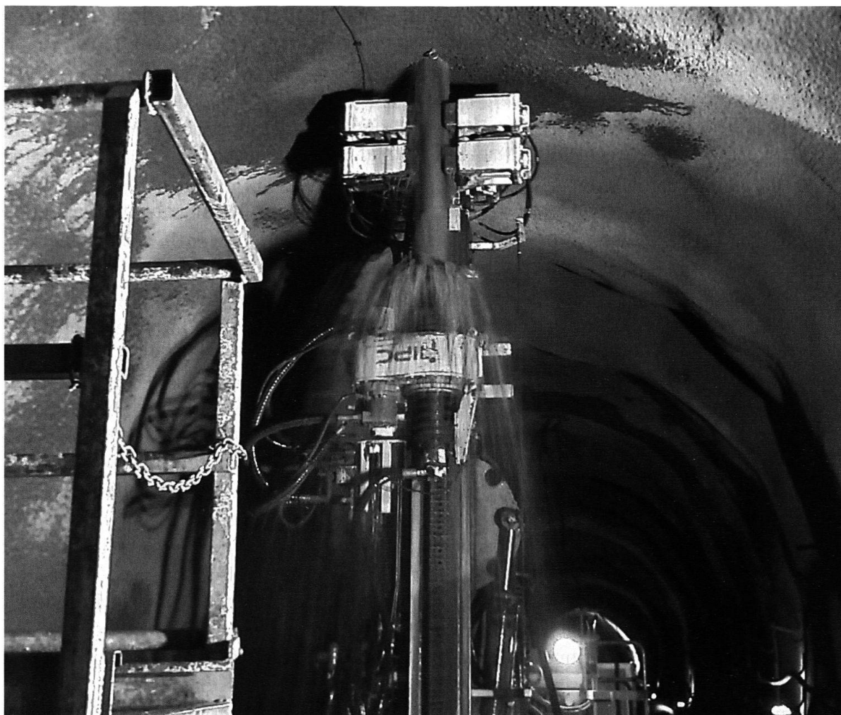
Figure 3.—Forage des drains remontants à partir de la galerie de drainage sous le glissement de La Frasse; les débits sont momentanément importants en cours de forage, mais se sont fortement réduits (photo extraite de SOLDINI et al. 2009).
