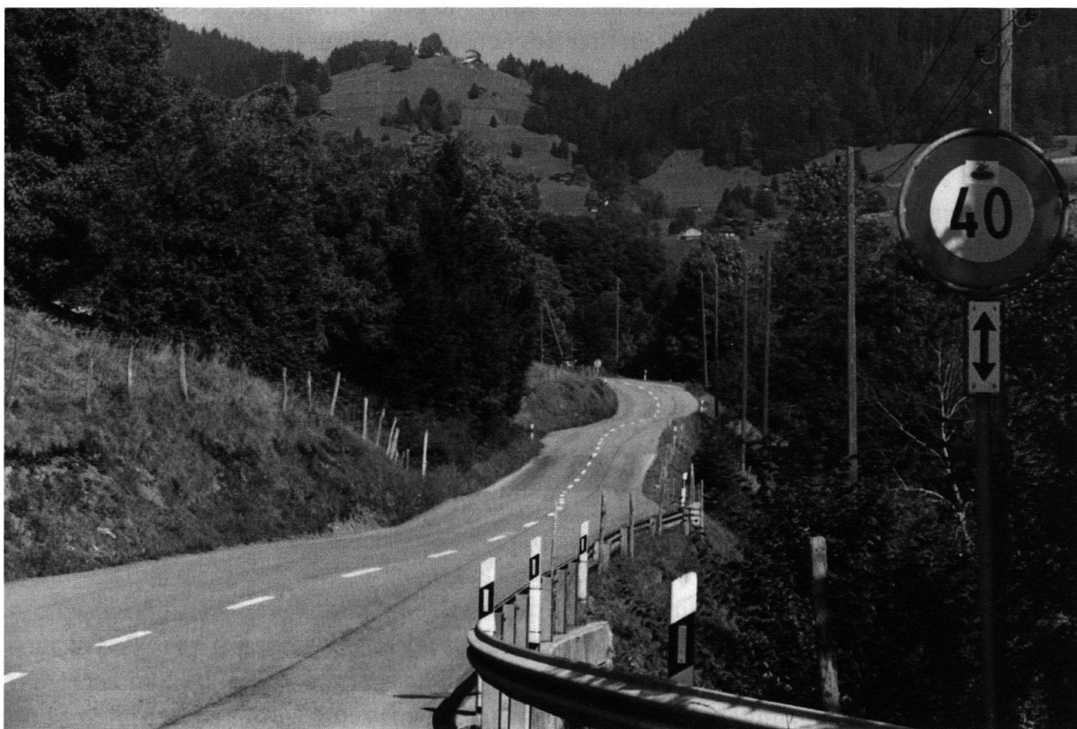
Figure 1.–La route RC 705, au droit du glissement de La Frasse, subit des déformations importantes, depuis sa construction en 1830, et nécessite des travaux d’entretien coûteux. (Photo: E. Prina)
