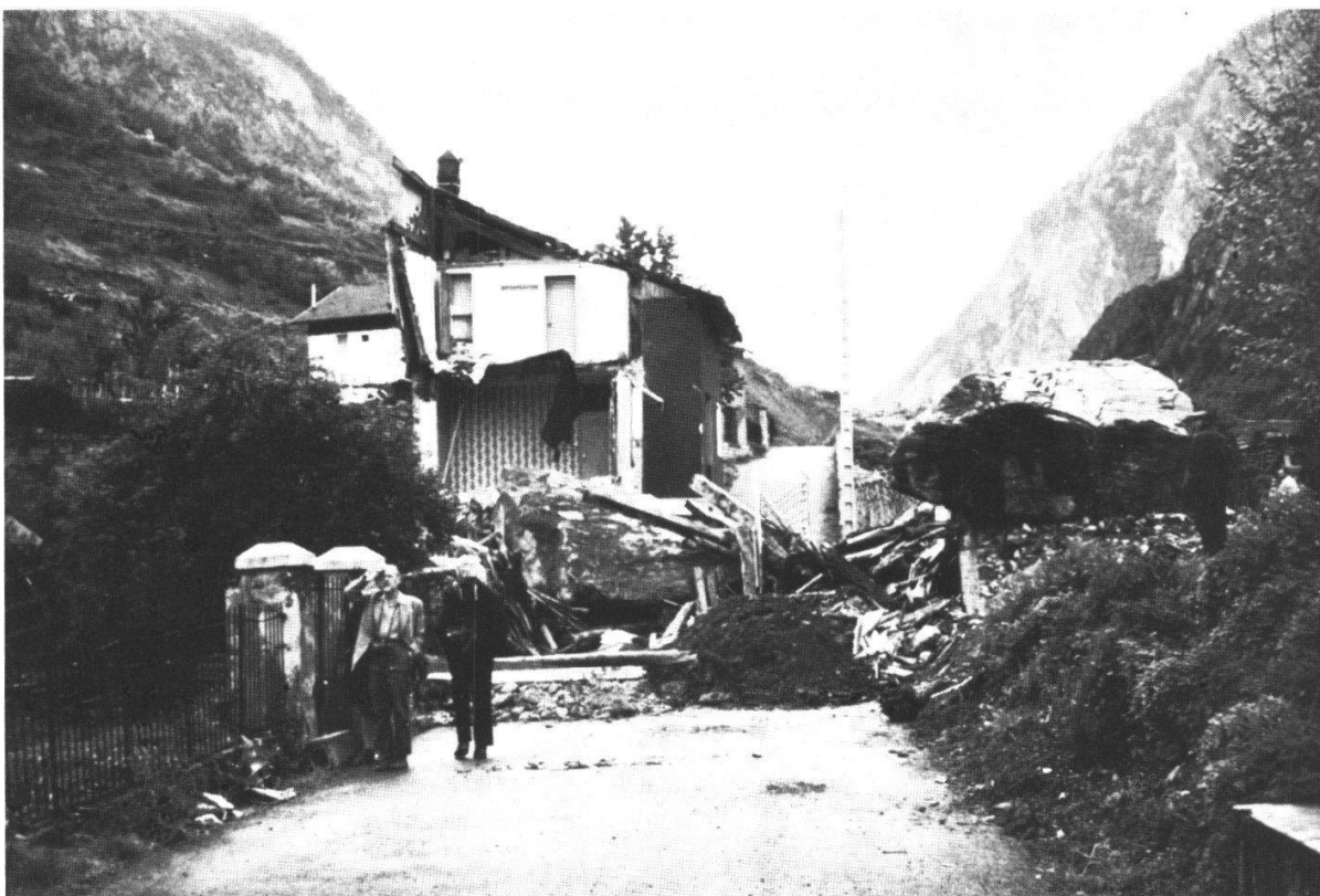
Photo 4. – Eroulement d'Aigueblanche. L'une des deux maisons détruites par les énormes blocs de brèches jurassiques. Celui de droite s'est arrêté sur le quai de la gare S.N.C.F.
