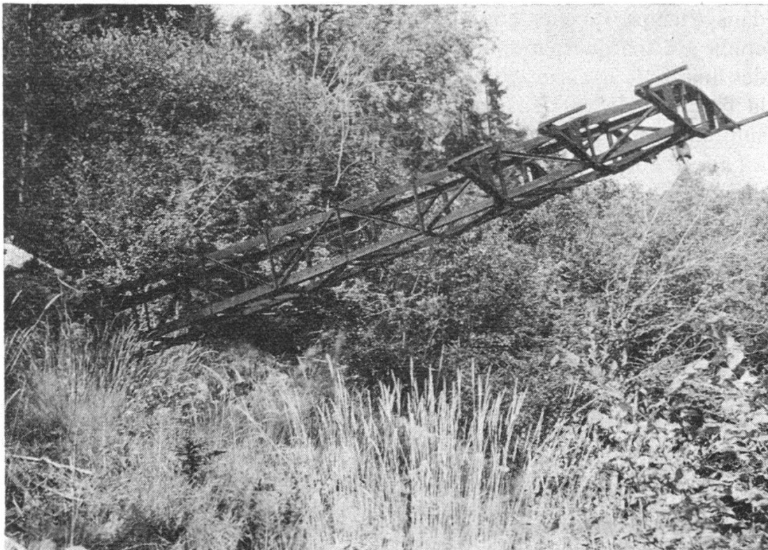
Fig. 3. — Pylône basculé par le glissement des Fontanelles.
