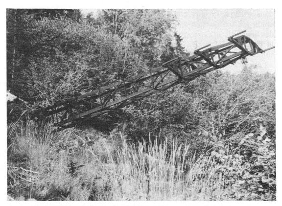
Fig. 3. — Pylône basculé par le glissement des Fontanelles.
