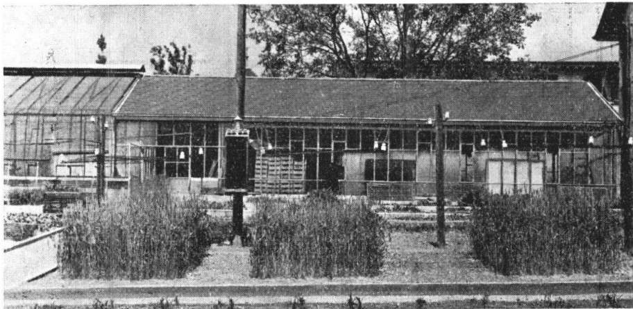
FIG. 9. — Vue partielle de 3 plans d'essai, avec champs artificiels. En arrière, sur poteau, le poste redresseur.
