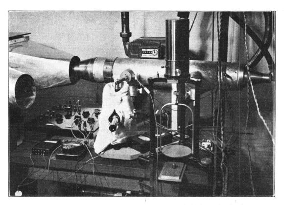
Fig. 11. — Troisième dispositif de mesure des densités ioniques (G Joyet), pour la mesure des ions lourds et des ions légers. Champs électriques parasites supprimés. Courant ionique compensé par un quartz piézo-électrique.
