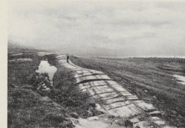
Photo. M. Lugeon, 1922. Fig. 8. Moitié Sud de la route crevassée et canal éternel.
