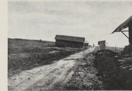
Photo. M. Lugeon, 1922. Fig. 10. Moitié Nord de la route avec bourrelets de compression.
