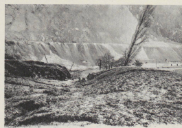
Photo. M. Lugeon, 1922. Fig. 6. Gouffe déversée 11 à gauche et gouffe 8—9—10 à droite; vue vers le Sud.
