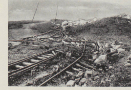
Photo. M. Lugeon, 1922. Fig. 11. Zig-zag des voies au Sud de la nappe.
