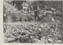
Photo. E. Buis, 1923. Fig. 12. Vestiges de voies redressées dans la « nappe noire ».
