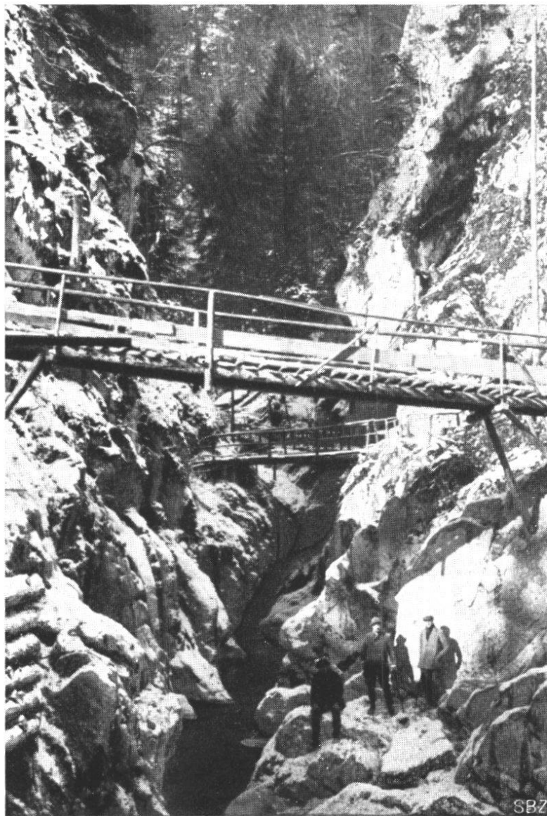
PHOTO 7. — La gorge asséchée de l'axe I à l'axe B.
