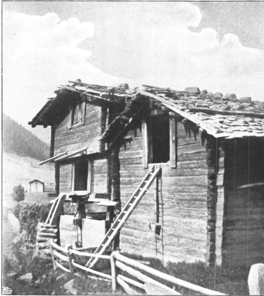
Grange et fenil à Muhlibach.
