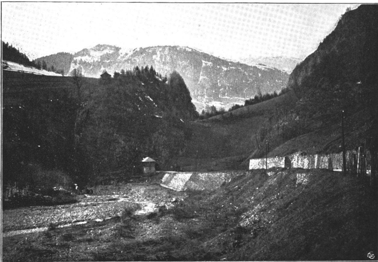
Fig. 2. — Vallée de la Dranse sur Biot en aval de St-Jean d'Aulph. (Vue prise de l'amont vers l'aval.) A gauche gorge naturelle; à droite ancien thalweg occupé par l'alluvion glaciaire.
