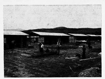
Abb. 7: Wiederaufbau. «Prefabs» (= vorfabrizierte Häuser) werden aufgestellt.
