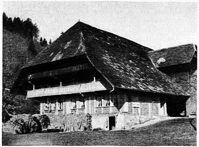
Älteres Berner Haus (Haulistal, Werthmüller, 1698). Bild 8. Das Schindeldach mit dem verkürzten Gerschild und mit der Einfahrt, die beiden vorderen Lauben, die freundliche Fensterfront der Stuben und Gaden, der Steinsockel aus Moränenmaterial, das Holz vor dem Haus sind die Merkmale dieser noch nicht umgebauten älteren Berner Häuser. Jahrhunderte langes Verbleiben in derselben Familie ist oft der Grund der guten Erhaltung, wie in diesem Beispiel.
