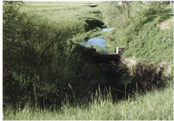
Fossé, retenue et perte, d'arrière en avant
