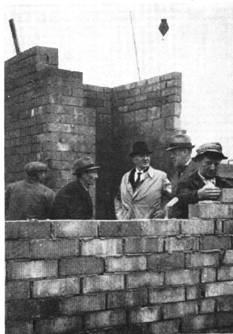
Lors de la construction du Laboratoire suisse de recherches horlogères dont il fut le promoteur (1939)
