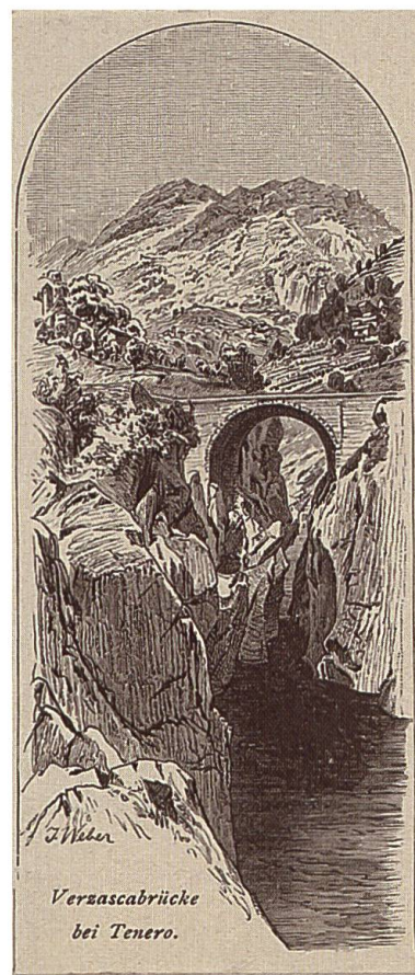
Figura 1: Ponte sulla Verzasca vicino a Tenero (1884). ASTi, Catalogo delle Stampe, LO D4 20.
