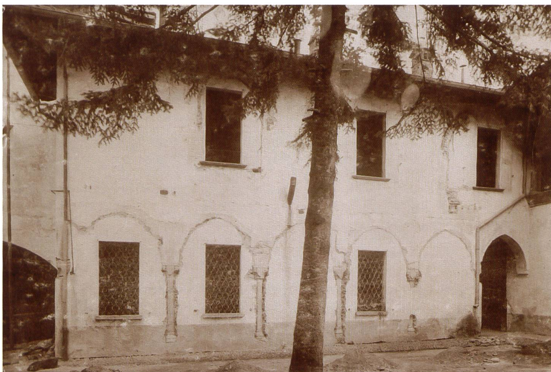
Facciata nord verso il cortile. (Porticato e Salone Conte P. Rusca) prima del restauro. Archivio della città di Locarno, Restauro del castello 1922-1926, fotografie.
