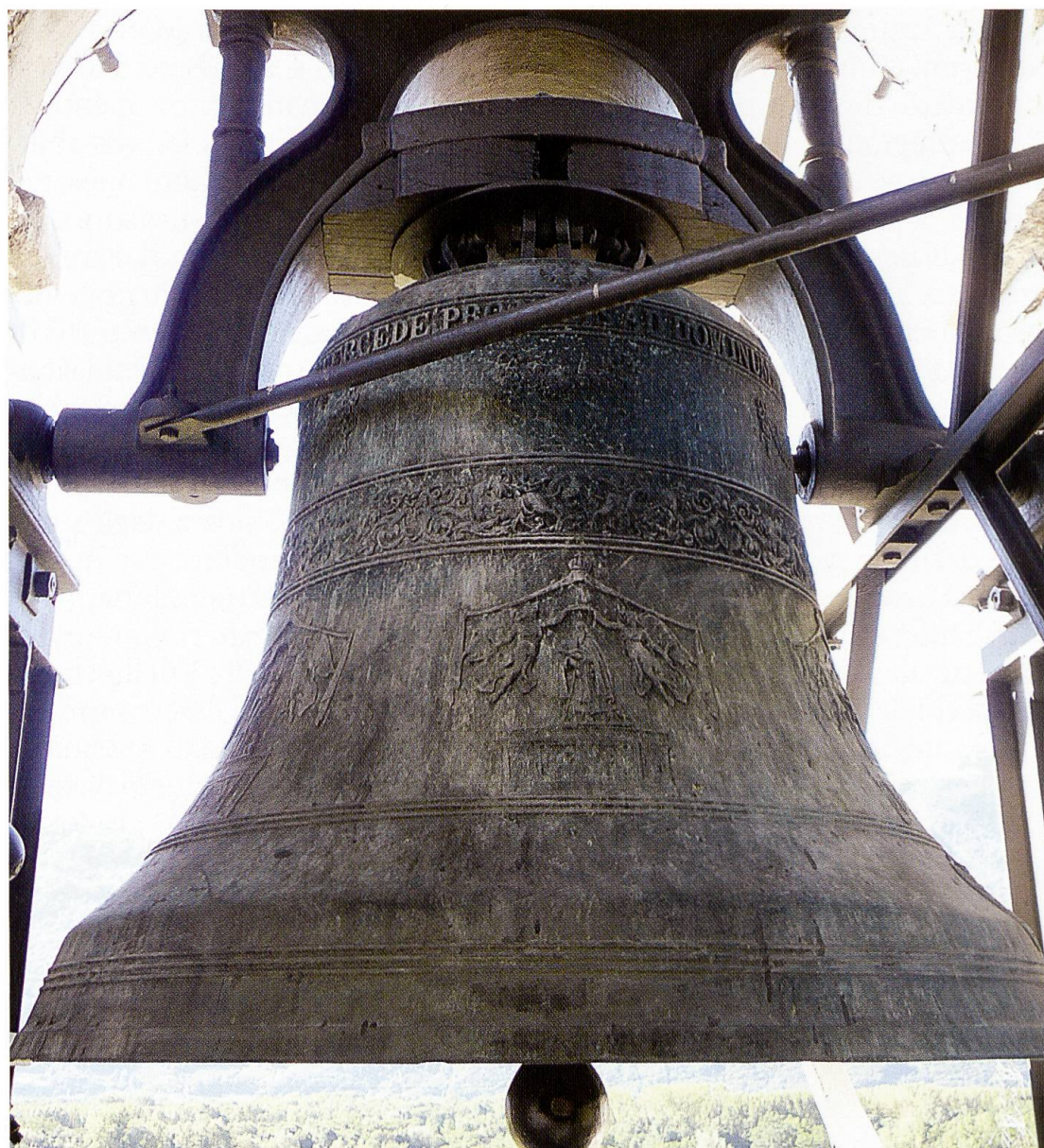
Seconda campana maggiore della parrocchiale di Cugnasco, fusa dai fratelli Barigozzi a Locarno nel 1849. La forma particolare della campana, più allargata rispetto alle sagome tradizionali, è caratteristica del metodo Barigozzi; le maniglie sono sostituite da asole di ferro.
