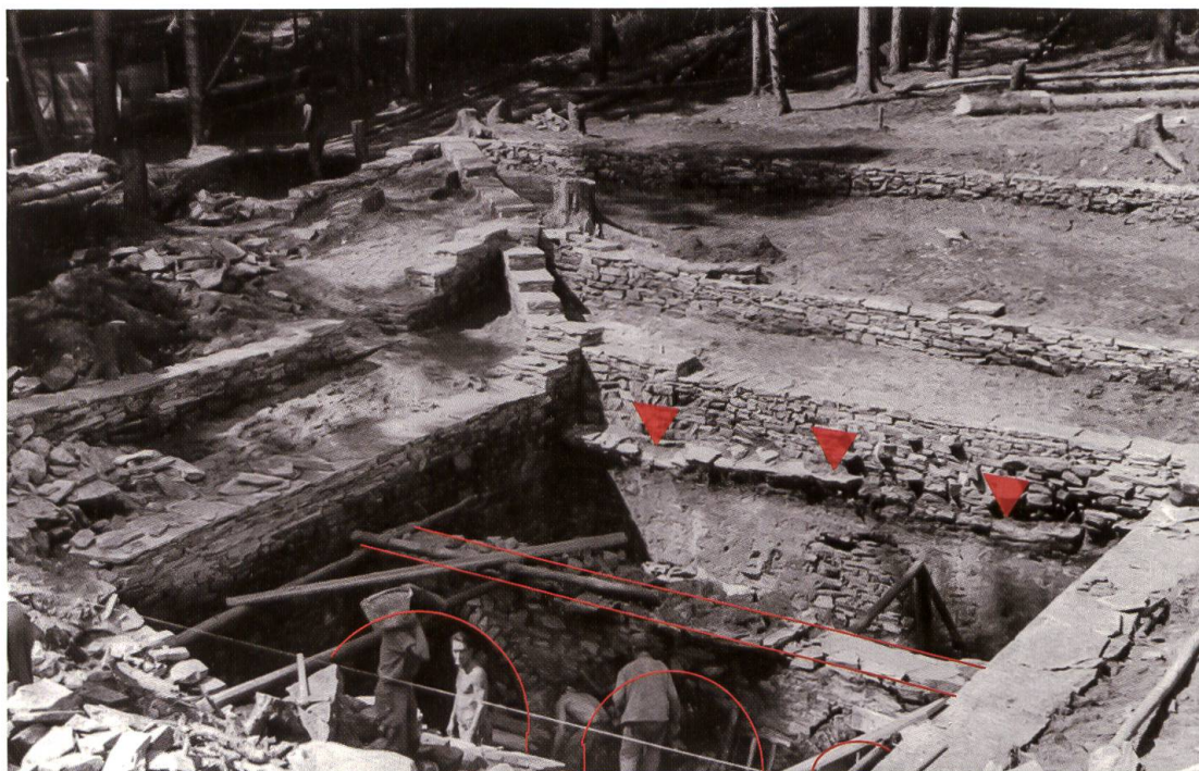
Fig. 6. Vista nord-ovest dell'edificio B1 in corso di restauro. In rosso è evidenziata la struttura ad arco, in secondo piano è visibile la base della volta a botte (frecce). ArCJ, Fonds Alban Gerster, Tegna, modificata dall'autore.
