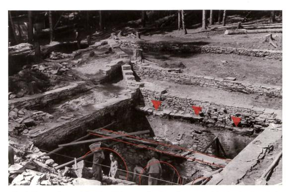
Fig. 6. Vista nord-ovest dell'edificio B1 in corso di restauro. In rosso è evidenziata la struttura ad arco, in secondo piano è visibile la base della volta a botte (frecce). ArCJ, Fonds Alban Gerster, Tegna, modificata dall'autore.
